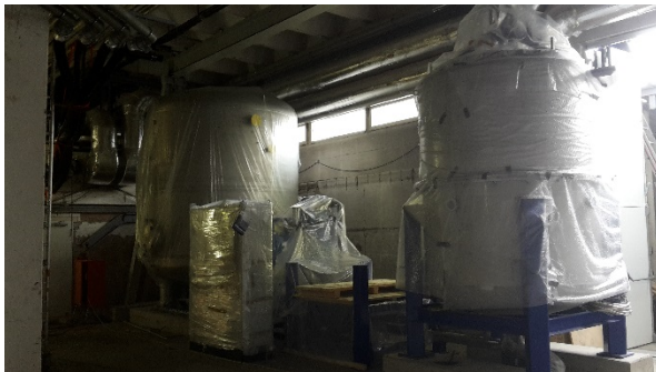
Bild 5 - Eisspeicheranlage
