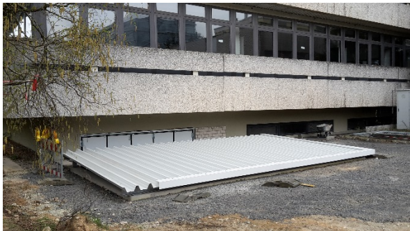
Bild 7 – Abdeckung Einbringschacht
